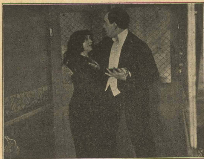
I Hotellets Elevator, mens Flammerne raser udenfor.
